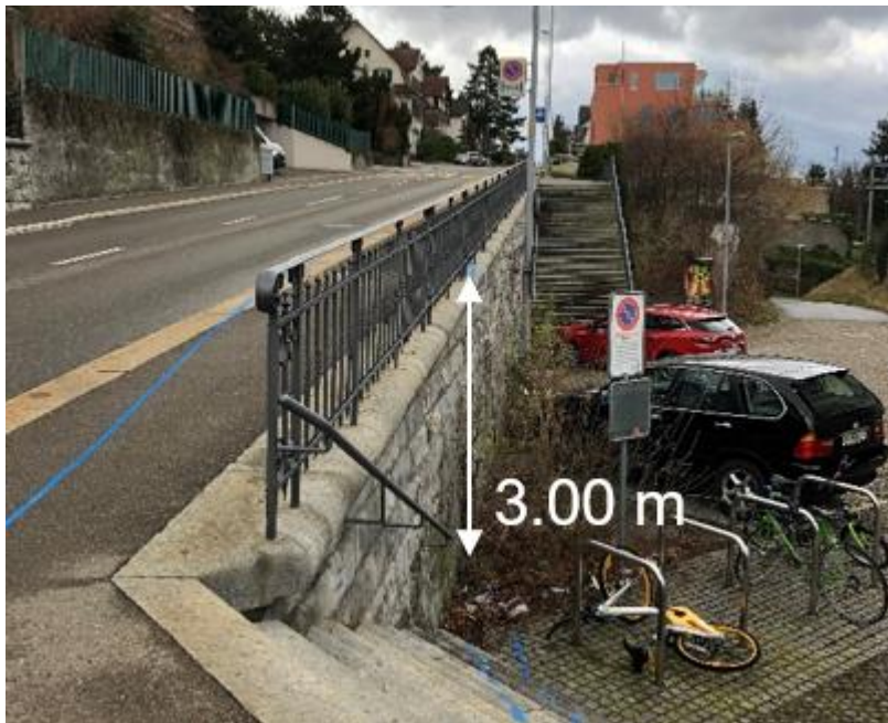
Abbildung 4: Normalprofil / Stützmauer H = 3 \text{ m} / keine Bewehrung gemäss Sondage
