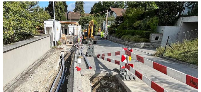
Werkleitungs- und Strassensanierung an der Weltistrasse.
