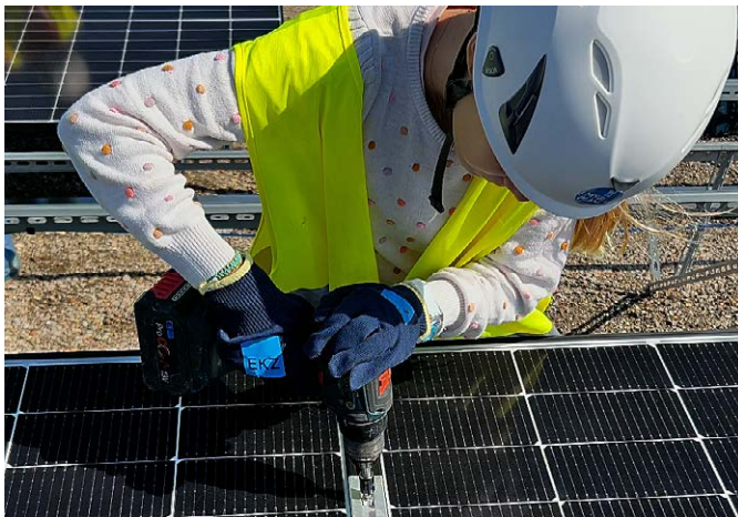
Selbst Hand anlegen: Die Kinder halfen bei der Installation der Solaranlagen auf dem Schulhausdach Oescher mit.
