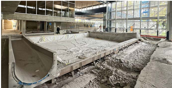
Die Sanierungsarbeiten im Schwimmbad Fohrbach haben begonnen.
