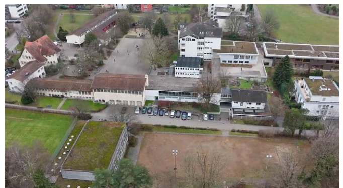
Auf der Schulanlage Rüterwis wird ein provisorisches Betreuungshaus als Übergangslösung errichtet.
