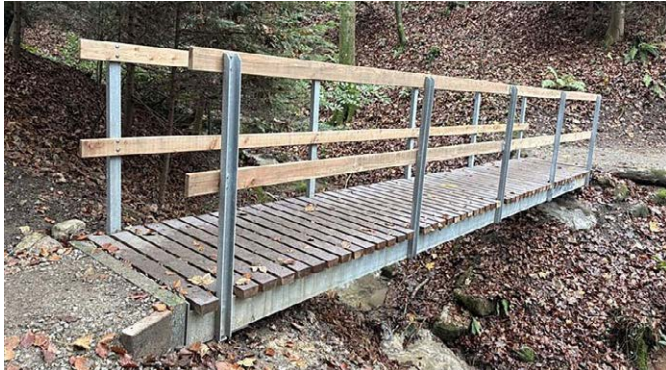
Die neue Brücke im Bereich «Im Chüelen Grund».
