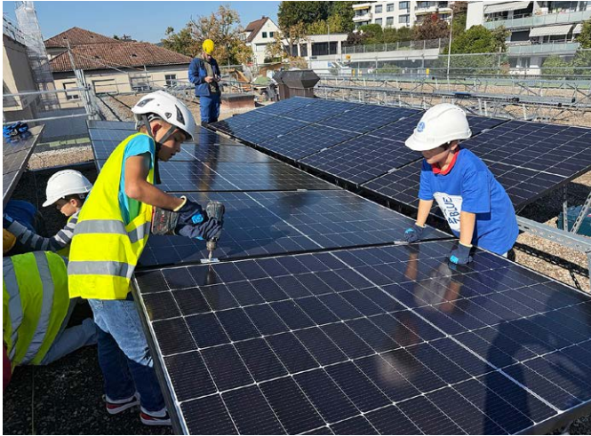
Mittelstufen-Schülerinnen und -Schüler packten im Rahmen des Aktionstags Solarenergie bei der Installation der Photovoltaikanlage auf den Dächern ihres Schulhauses mit an.
