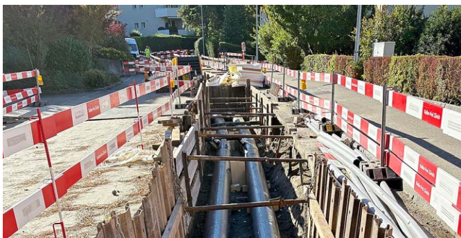
Die Bauarbeiten zum Ausbau des Fernwärmenetzes sind gestartet.
