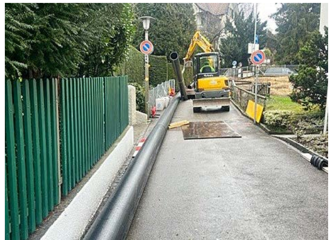
Kanalarbeiten in der Sägegasse.
