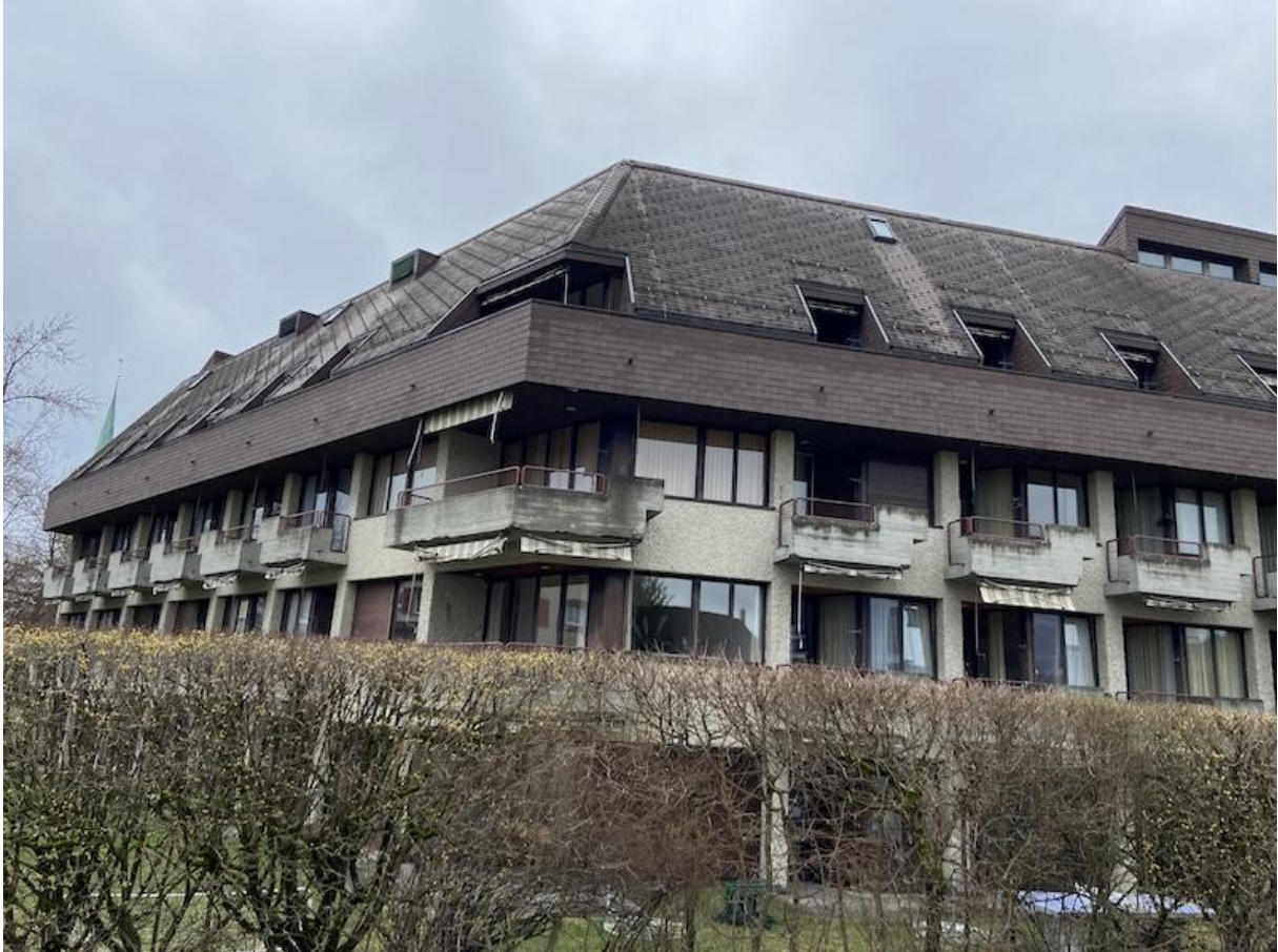
Ehemaliges Altersheim Beugi: maroder Betonklotz (Fotos: ZN)
