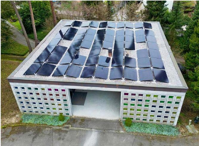
Photovoltaikanlage auf dem Dach der Abdankungshalle des Friedhofs Dorf.
