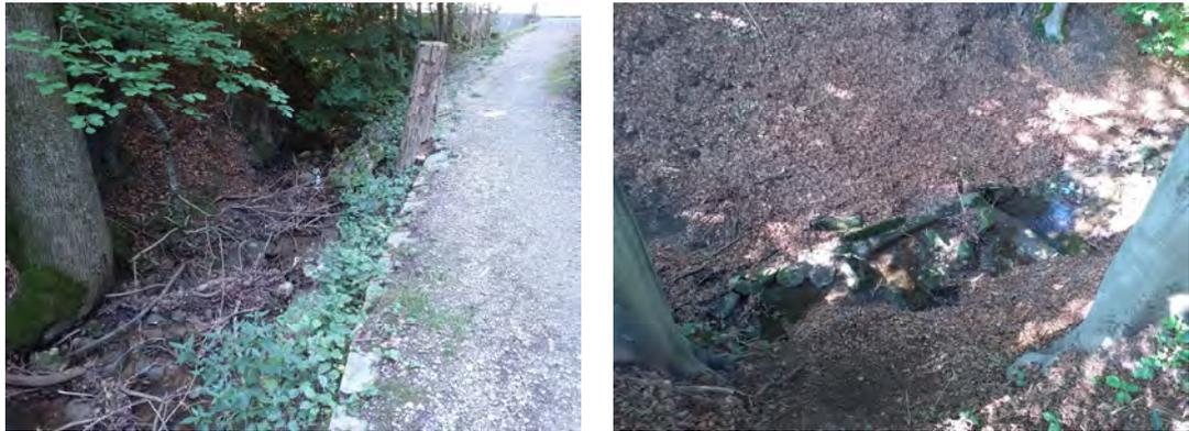
**Abbildung 59:** Blick auf Abschnitt Düg\_05, vor Durchlass Alte Landstrasse, die Höhendifferenz zwischen Bachbett und Strasse beträgt 2.5 m (Bild links). Blick auf Abschnitt Düg\_04, nach Durchlass Alte Landstrasse, die Höhendifferenz zwischen Bachbett und Böschungsoberkante ist grösser als 3.0 m.
