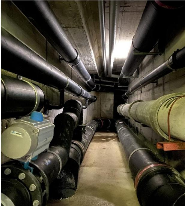
Abbildung 15 Leitungsgang mit Beckenverrohrung Freibad
