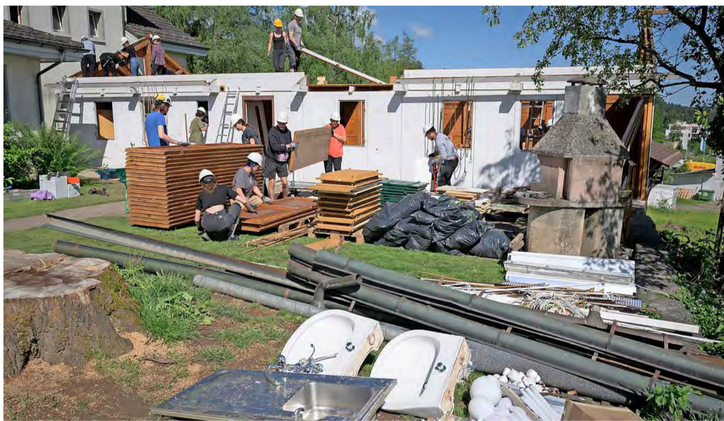
Rückbau bei der Klinik Schlössli in Oetwil: Das Dach des Pavillons ist schon weg. Foto: Michael Trost
