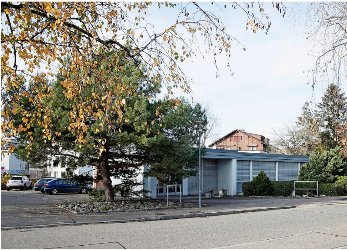
Hier entsteht in den nächsten Jahren ein Gewerbe- und Wohnhaus. Der Gemeinderat sieht vor, im Untergeschoss die Bibliothek einzumieten. Foto: Moritz Hager
