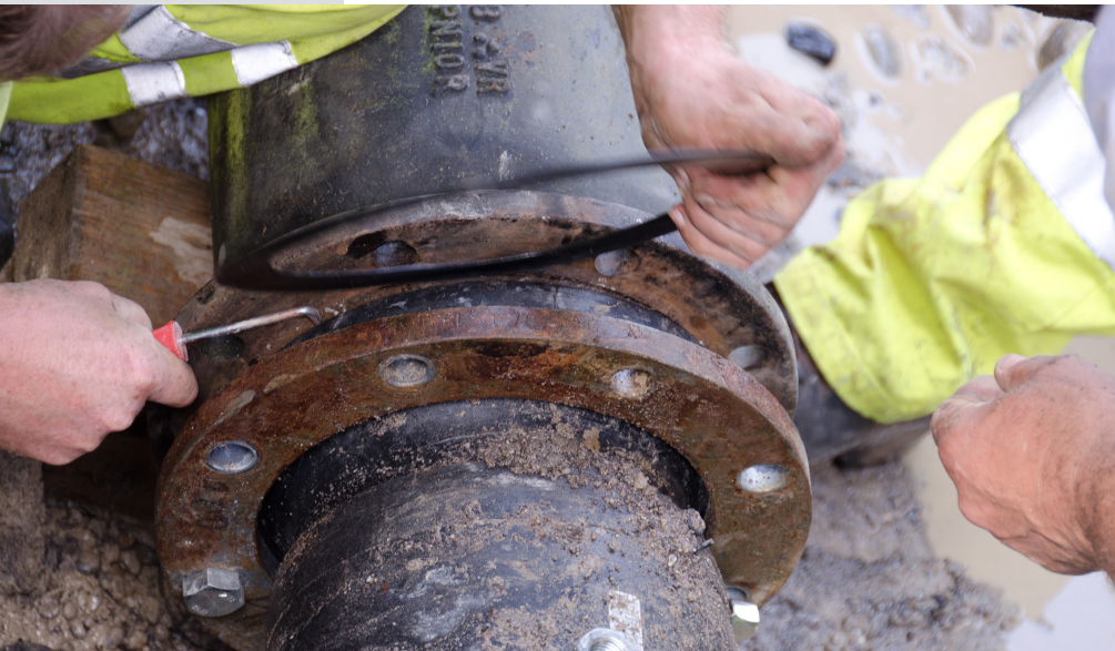
Zusammenschrauben einer Flanschverbindung
